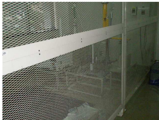
安全柵外からの状態
